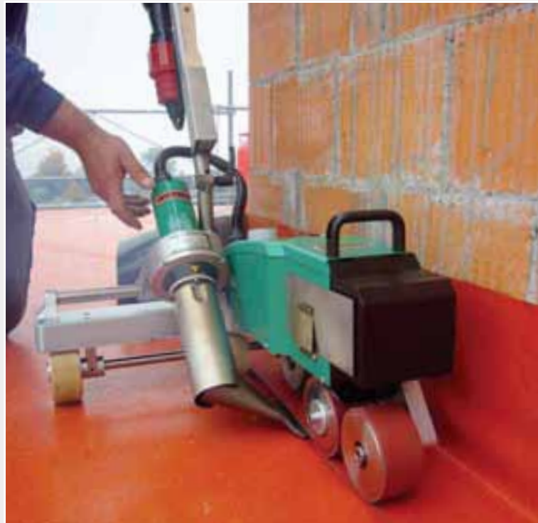
得益于其细长的流线型设计，它可以在4英寸这样狭窄的空间中进行焊接操作。
